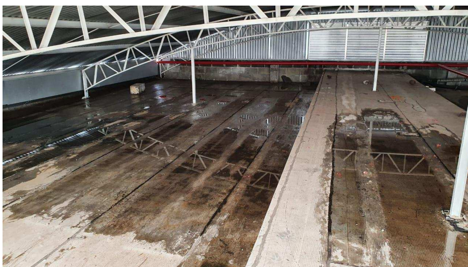
Alagamento abaixo da cobertura metálica e de policarbonato do TRE-PR após os furos ocasionados pela chuva de granizo
